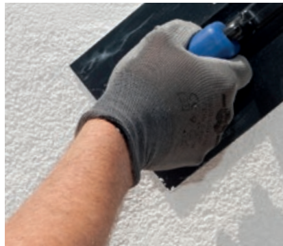
Dünnputz (z.B. Baumit SilikonPutz, Baumit SilikatPutz) auftragen und strukturieren.
