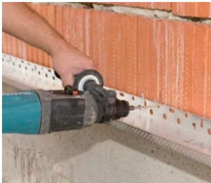
Sockelprofil in Plattendicke mit Dübel befestigen und z.B. mit Baumit KantenFix verkleben.
