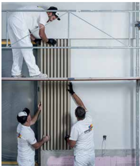
Austrotherm Resolution® homlokzat – optimálisan szigetelve 300 mm vastagságban
