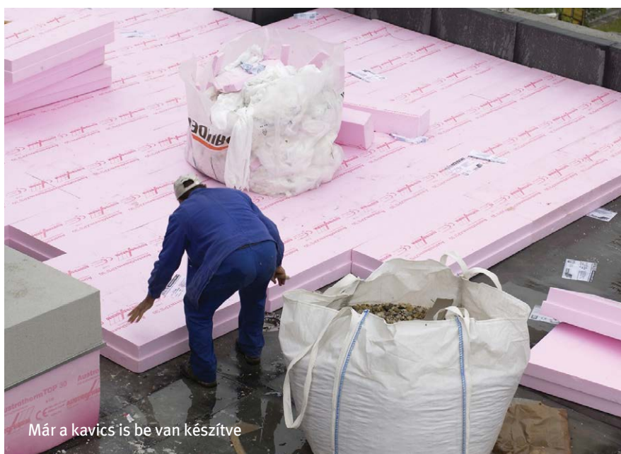
Lapostető hőszigetelése fordított rétegre
