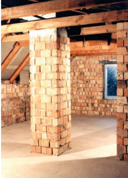
Kész a padlás hőszigetelése
