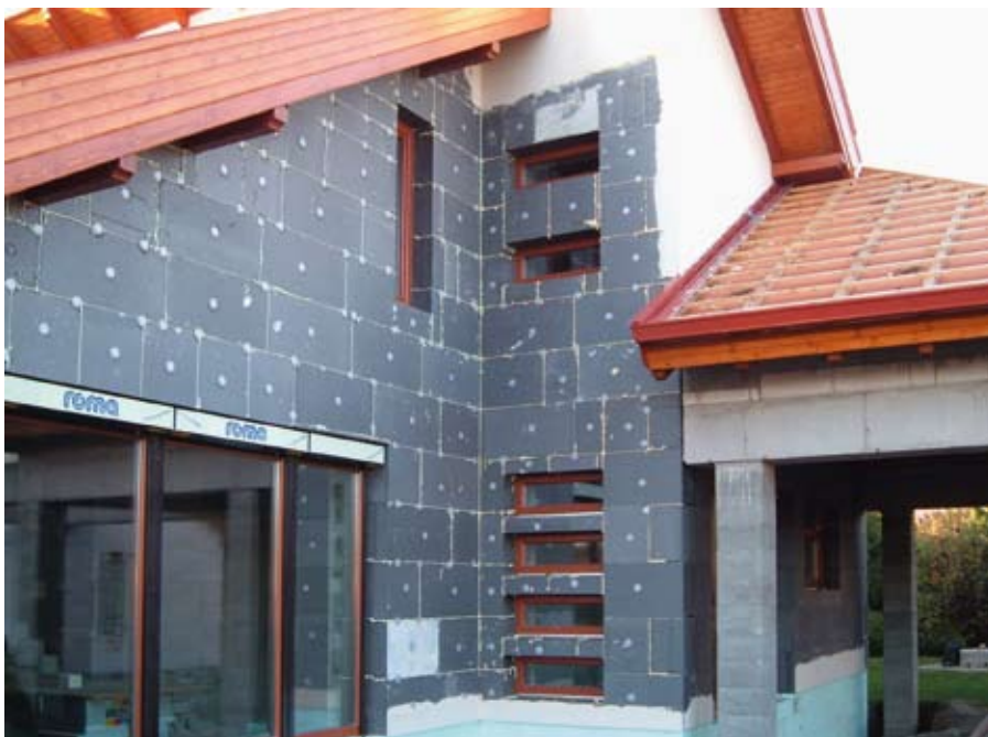
Passzívház építés Orosházán
