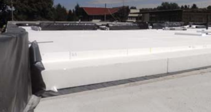
A lejtésképző elemek elhelyezése az AUSTROTHERM által kidolgozott fektetési terv alapján könnyen és gyorsan végezhető.
