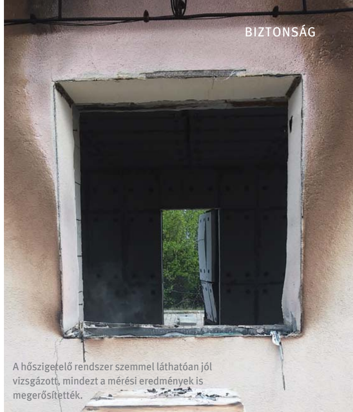
30 cm vastag grafitadalekos EPS a homlokzaton
