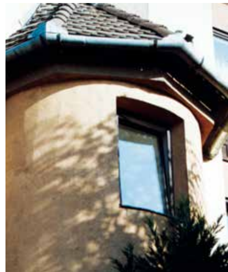
Utólagos hőszigetelés íves elemekkel.
