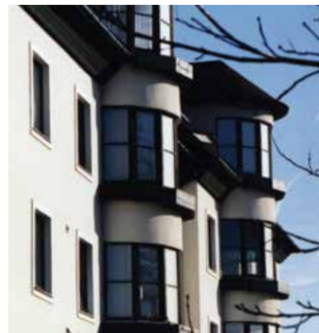
Utólagos hőszigetelés íves elemekkel.
