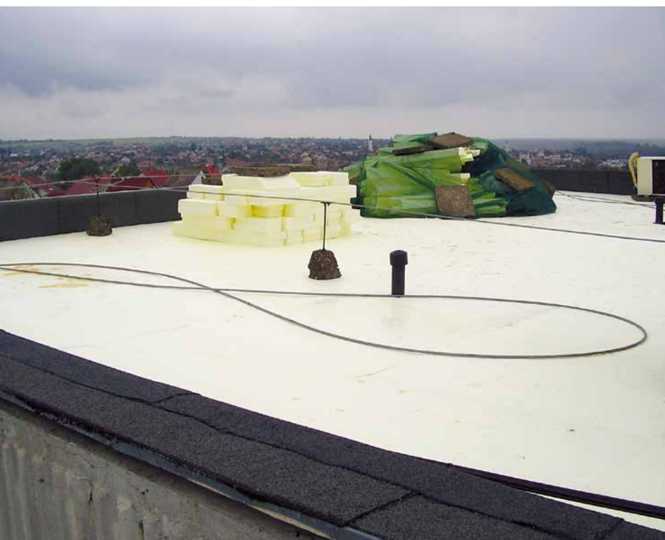
Lapostető felújítás Zenit® lemezekkel
