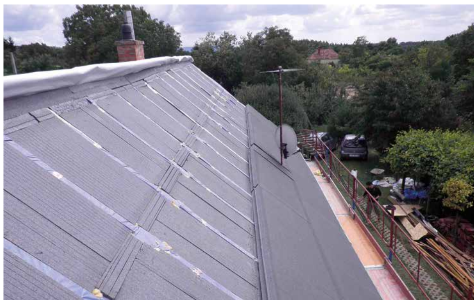
Tetőfelújítás Manzárd Grafit® alkalmazásával
