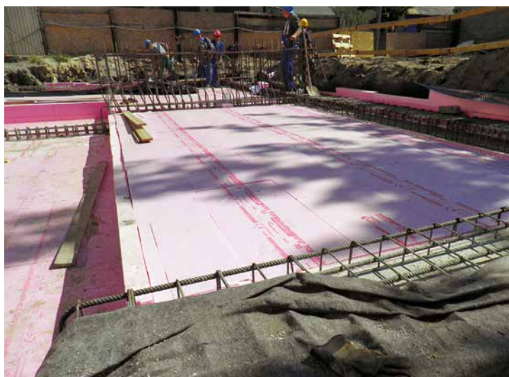
Talajba kerülő szerkezet hőszigetelése XPS lemezzel
