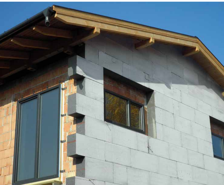
Passzívház homlokzati hőszigetelése
