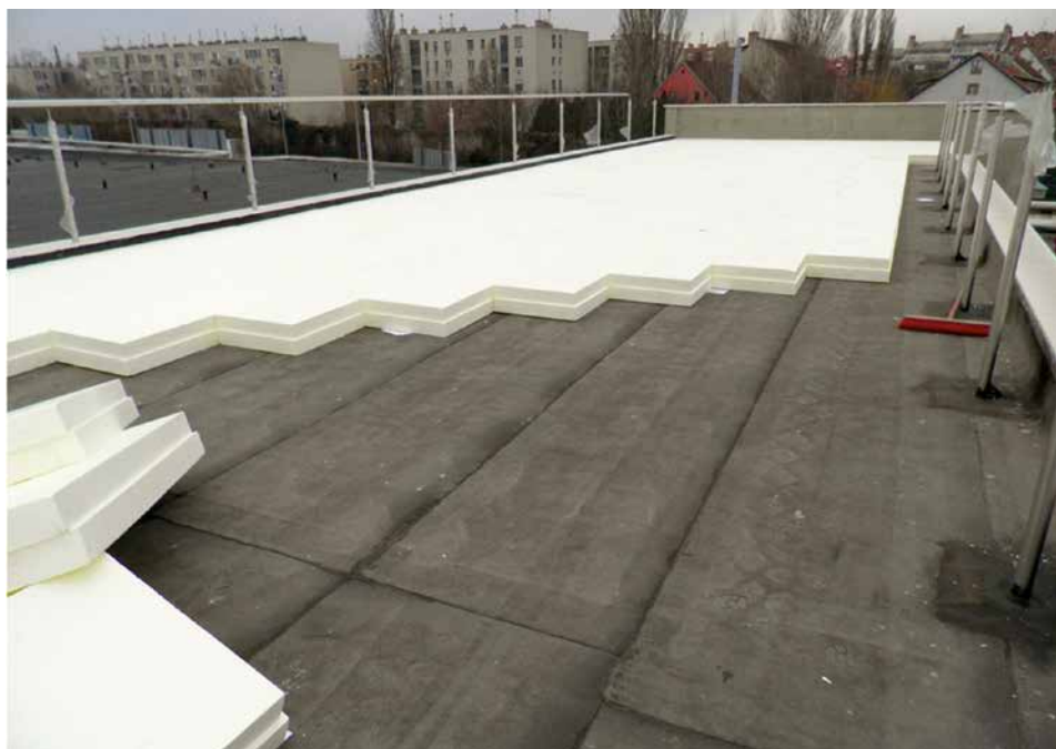
Zenit® hőszigetelő lemezek fordított rétegrendben
