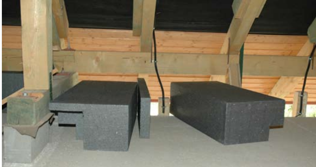
Födémzigetelés a tényői passzívház esetében
