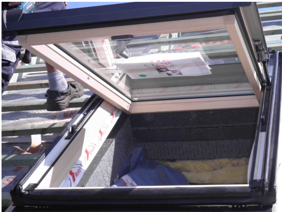
5. Tetősík ablak beépítés. Jól látszik a régi, vékony hőszigetelés, a Klemmfix® és a Manzárd Grafit® rétegek
